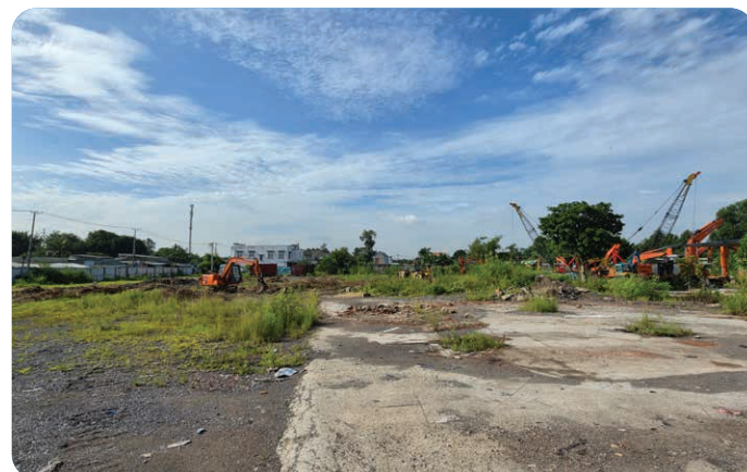
Kho bãi máy cơ giới + Dịch vụ sửa chữa chuyên nghiệp (đang thi công)
